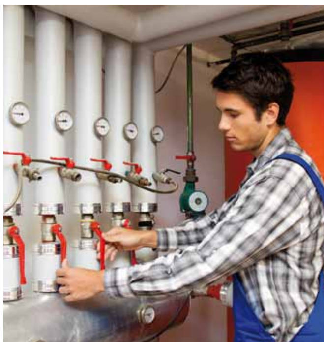
Ein Heizungspumpentausch lohnt sich: Moderne, energiesparende Pumpen passen die Leistung automatisch an!
